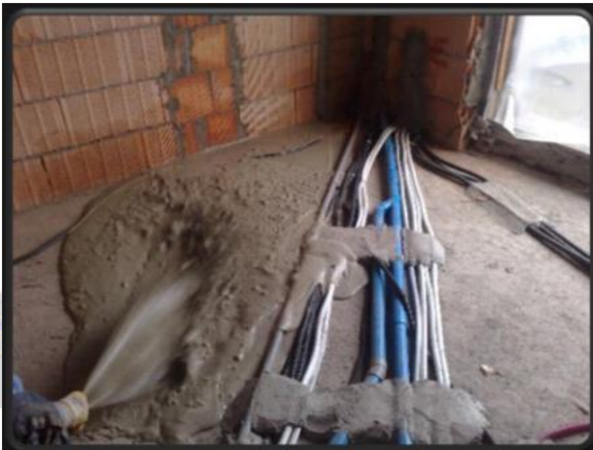
Realizzazione massetto di livellamento
